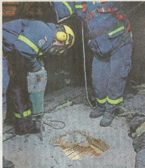
Mauerdurchbruch. Foto: THW-OV-Alzenau
