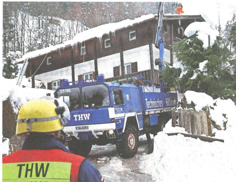
Der Kran des THW Marktheidenfeld dient der Sicherung der Akteure.
